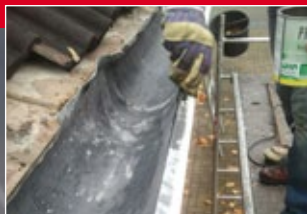
Reparatie van dakgoten
